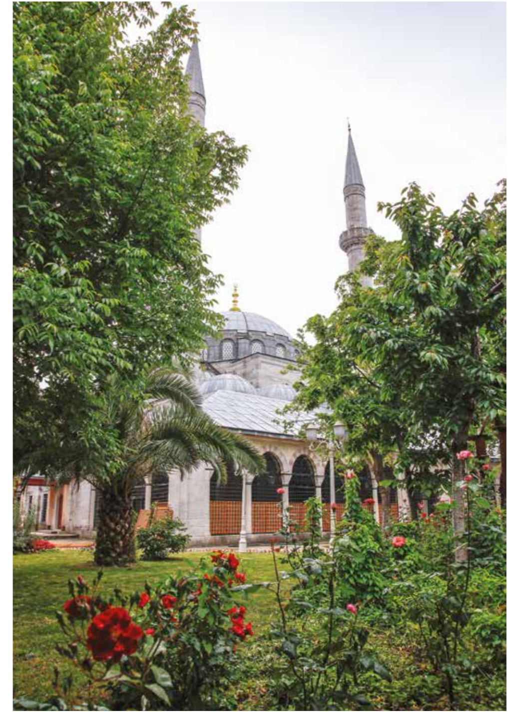
Atik Vâlîde Camii dış görünüşü.
